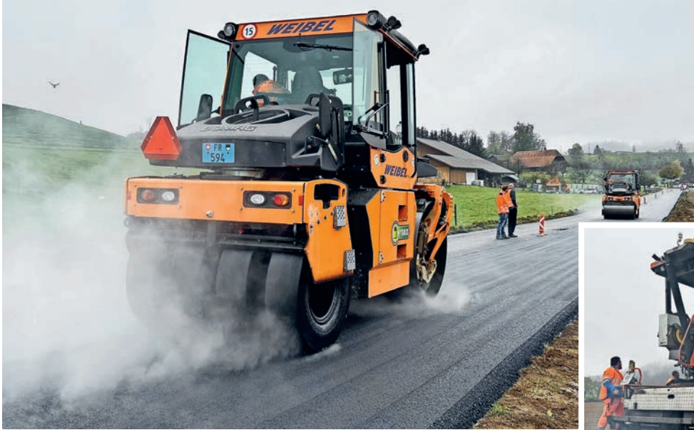
6 | Einbau der Deckschicht AC 11 N Bio in Riggisberg Anfang November 2024.
