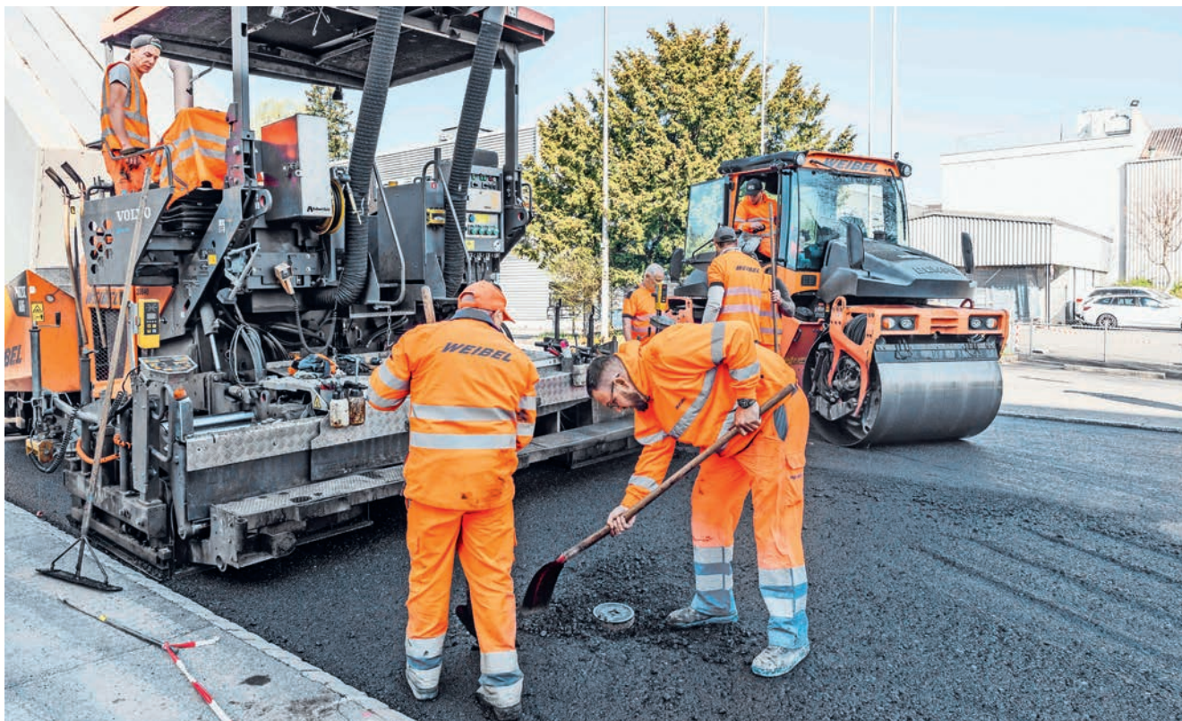
1 | Einbau von Asphalt aus BioBitumen auf einer Teststrecke in Köniz bei Bern.
