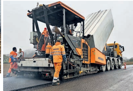
6 | Pose de la couche de roulement AC 11 N Bio à Riggisberg début novembre 2024.
