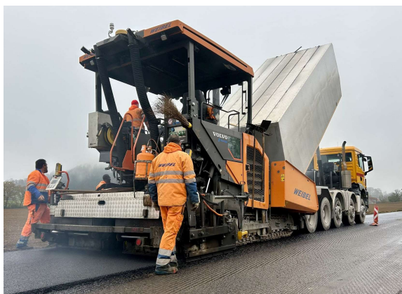
Fig. 3 : Pose d'une couche de roulement en « BioAshalt » à Riggisberg dans le canton de BE (automne 2024).
