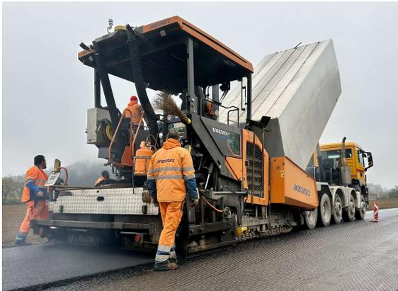
Abb. 3: Einbau einer Deckschicht aus BioAsphalt in Riggisberg im Kanton BE im Herbst 2024.
